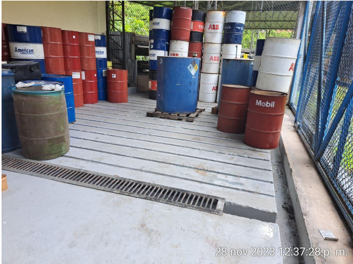
Fotografía N° 1. Piso de Almacén de Aceites usados y nuevos.
